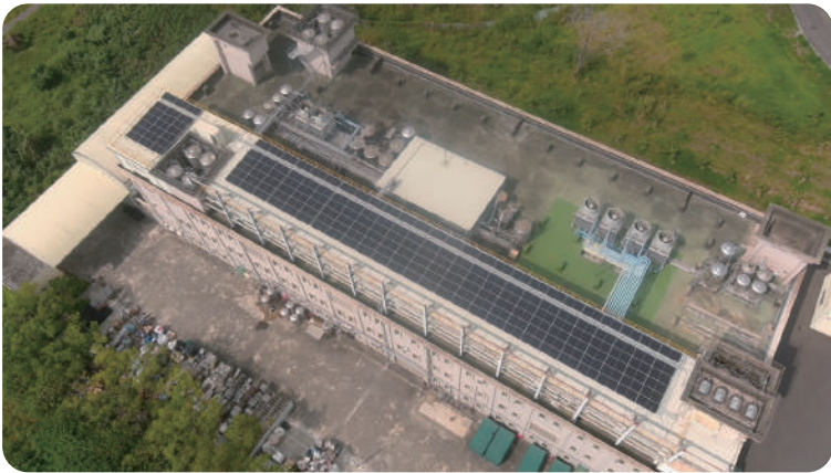
▲ 2024年屋頂型太陽能持續建構，第三期已安裝完成，待正式掛錶並網
