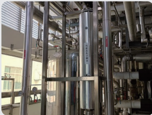
▶ 導入閃發蒸汽回收系統，將逸散的熱能回收至空調熱水減少天然氣使用量
